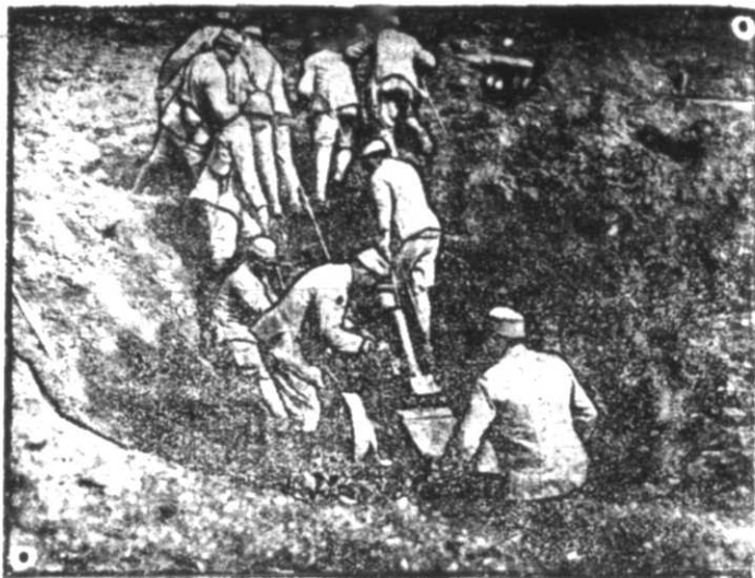
Cañón de trinchera en una excavación abierta por una granada
