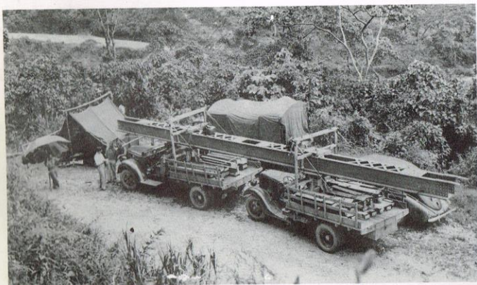
51. Transporte de las estructuras del Puente Eduardo Santos para el Rio Guatiquia Década de 1940 (Nótese la unión de los camiones)
