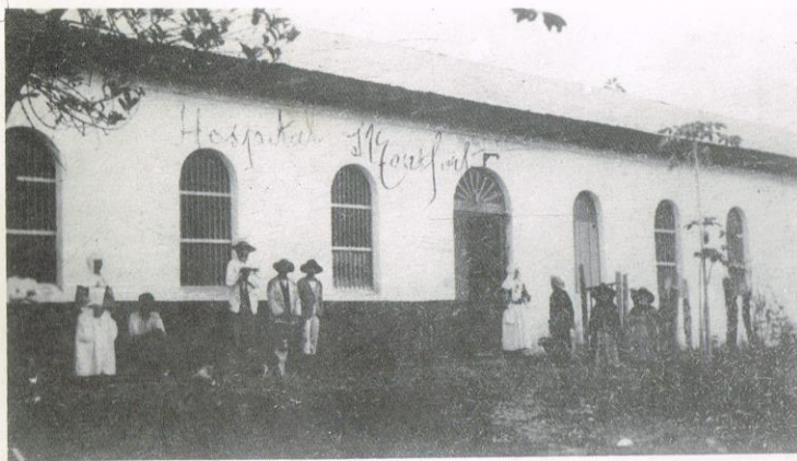
12. Hospital Montfort Década 1910
