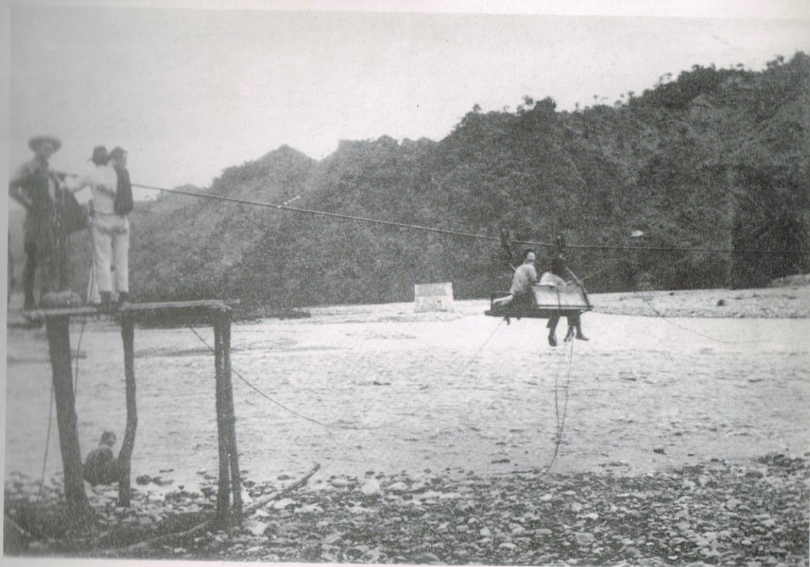
50. Paso del Rio Guatiquia en canasta (En obra base del puente Eduardo Santos) Década de 1940
