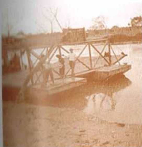
Planchón llamado Ferry, 1960. Embarcación que prestaba el servicio de paso de vehículos y carga, en el sitio denominado Ponteadero, hoy puente Carlos Lleras Restrepo.
