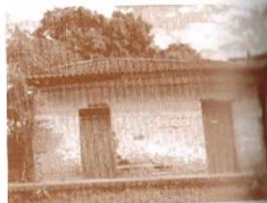
Vivienda hecha en bahareque , cubierto con tierra, paja y boñiga. Foto: 2009.
