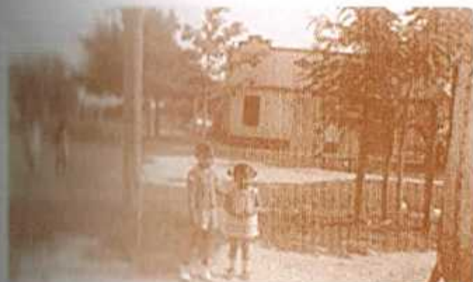
Caseta ubicada en el barrio Hueso limpio , más tarde denominado barrio Abel Rey, uno de los primeros barrios a orilla del río Metica y caño Banderas (ahí donde hoy, funciona la caseta comunal del mencionado barrio). Foto: 1960.
