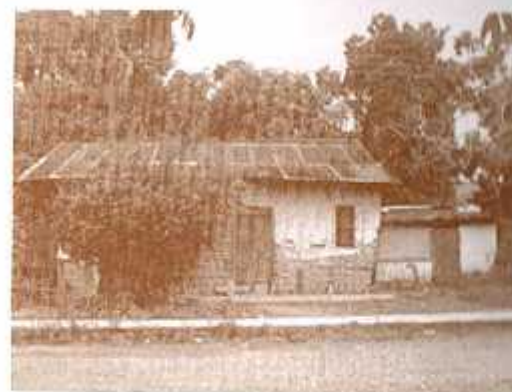
Primeras viviendas del municipio hechas en bahareque, cubierto con tierra, paja y boñiga. Casa que aún existe en el barrio Abel Rey. Foto 2010.
