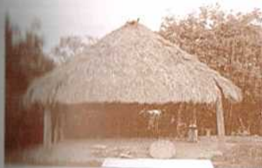
Maloca , vivienda construida por los indígenas, hecha en hojas de moriche o palma y estantillos; aún se observan en algunas fincas o en el resguardo indígena.
