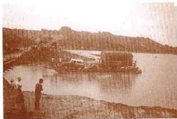
La ruptura de una de las alcantarillas de la carretera , cerca al sitio denominado Alto Menegua, dejó incomunicado a Puerto López con Puerto Gaitán, hecho que dio origen a la construcción de un nuevo puente. Julio de 1986.
