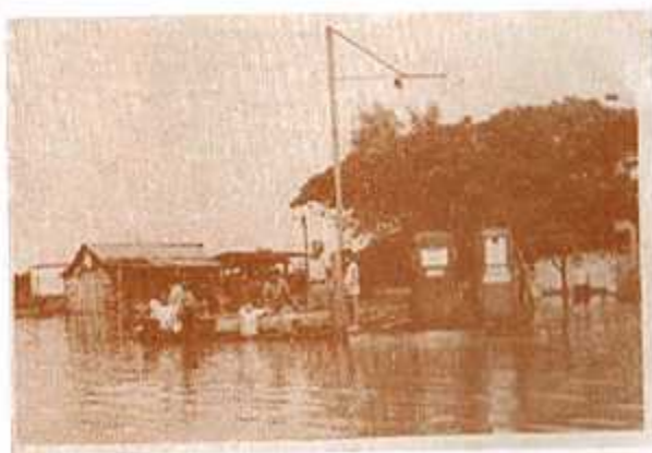
Bomba de gasolina de Puerto López, llamada bomba del Río, propiedad de Eliécer Duque, ubicada a orillas del río Metica; en tiempos de inundación los surtidores quedaban entre el agua. 1957.
