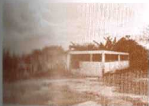
Vestigios del antiguo matadero del municipio, ubicado en las instalaciones del ICA, en el barrio La Variante, hoy barrio Porvenir. 1989.
