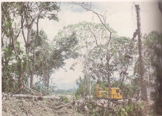
Martillo taladrando los huecos de soporte del puente provisional.
