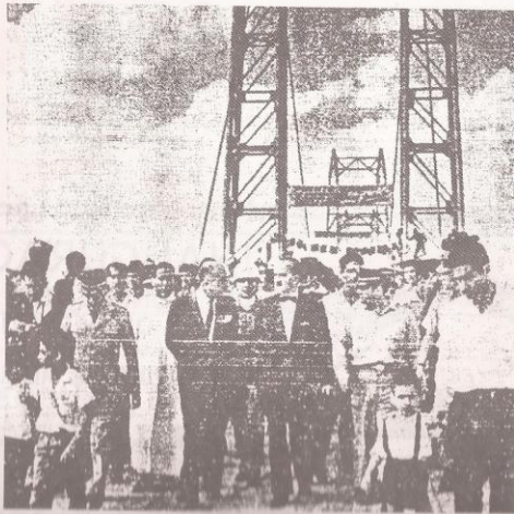
EN LA INAUGURACION DEL PUENTE ARIARI. Luego de la ceremonia de inauguración del puente, seis horas de la mañana, del
