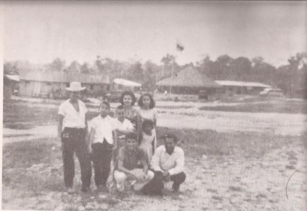
Después de la creciente grande que destruyó a PUEBLO VIEJO, se construyó nuevamente el poblado en el sitio de la CUBILLERA con el nombre de PUERTO CALDA
