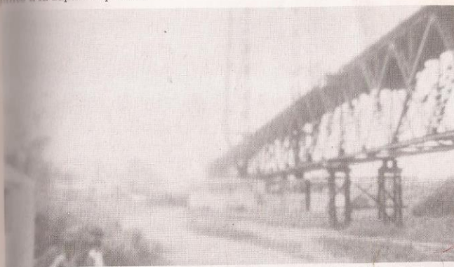
En las postrimerías de su construcción se pueden apreciar todavía los andamios sosteniendo la estructura. Al fondo PUEBLO VIEJO y al lado izquierdo el trailler del equipo de soldadura.
